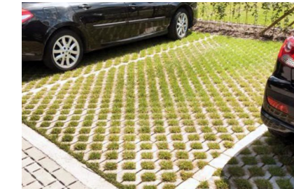
Parkeerplaatsen van grasbetontegels
