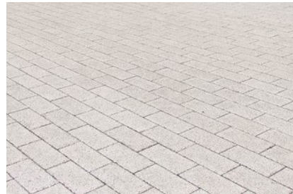
Padenstructuur en halte: Struykvervo infra-Betonstraatstenen 21mmx10,5mm In de grijskleur Lavara 010.
