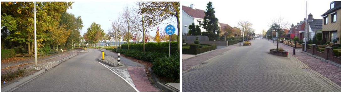
Figuur 11 wegversmalling met doorgaande fietsstrook en met uitstulpingen
