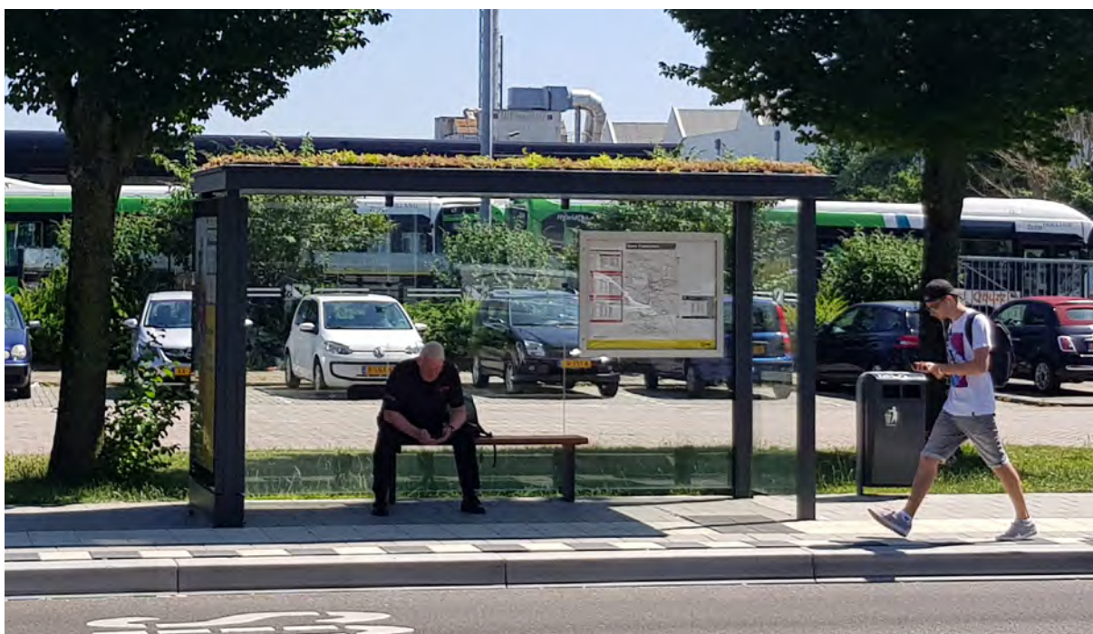
Sedumdak op abri
