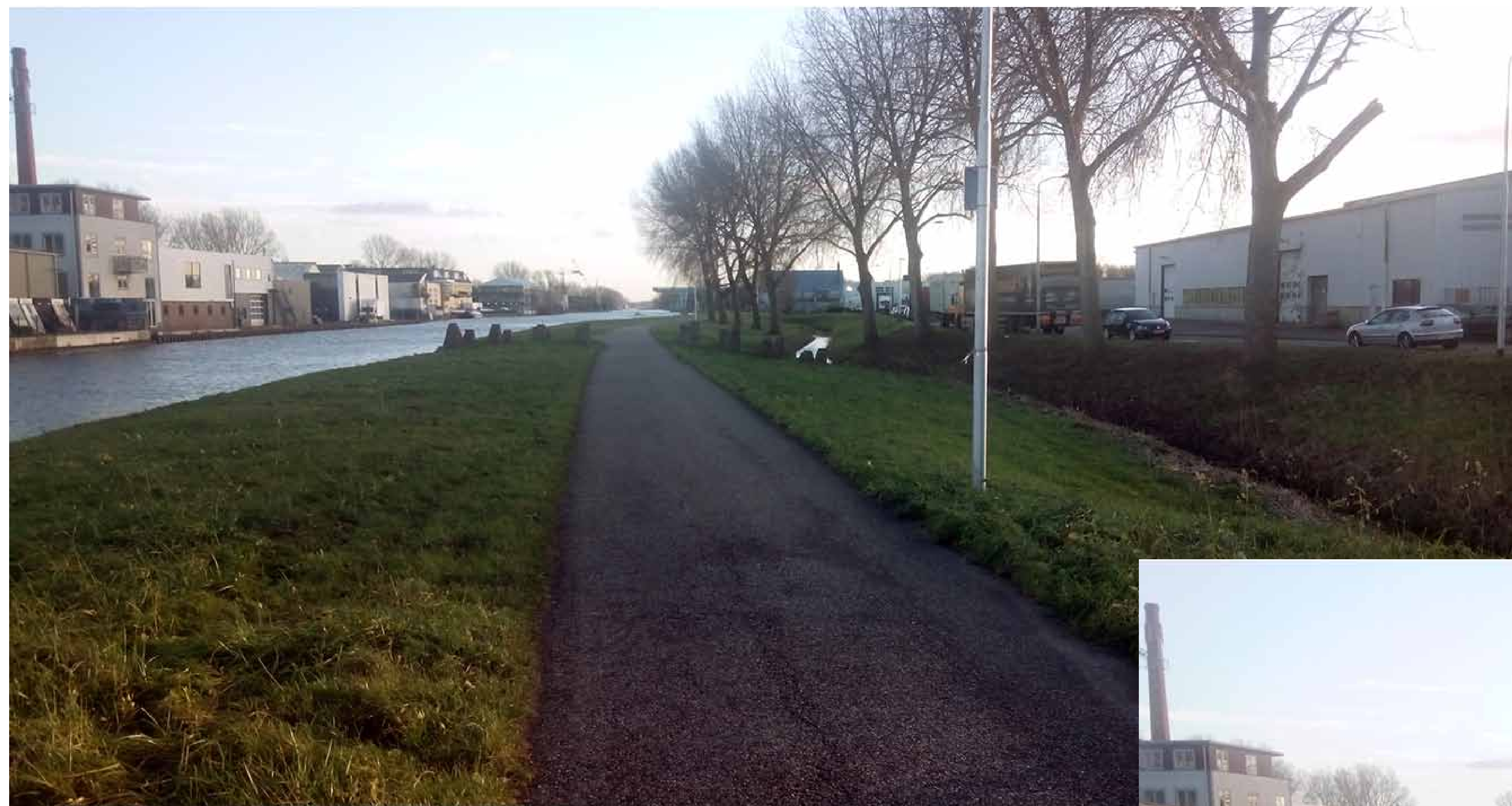
Schiekade bestaande situatie
