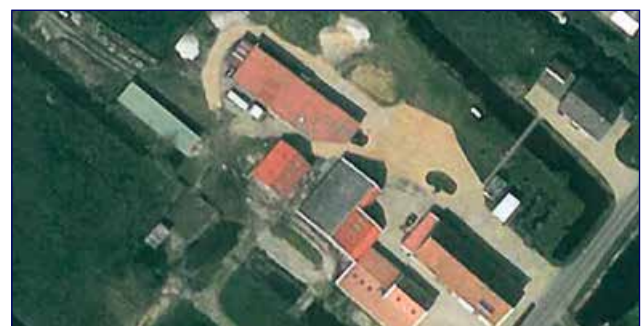
De bestaande boerderij, waarvan de stallen gesloopt zullen worden.
