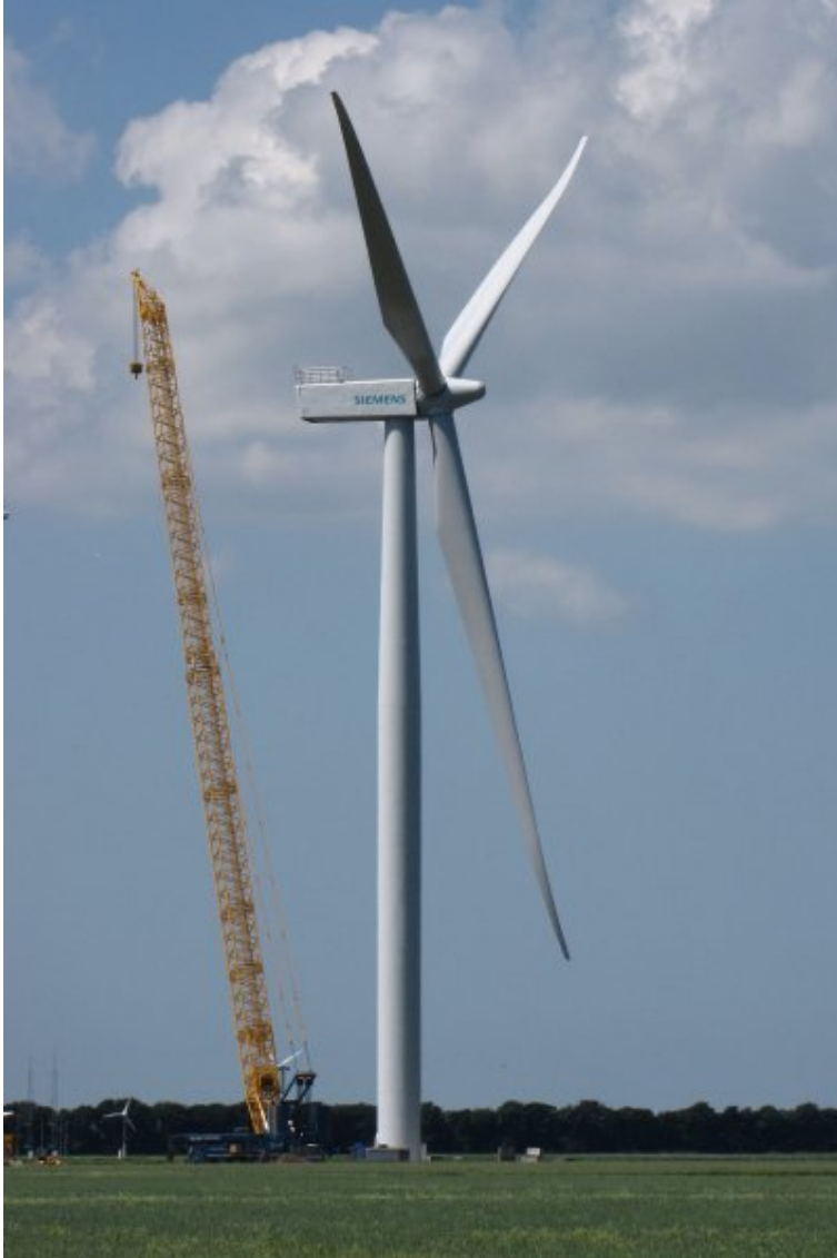
Voorbeeldturbine: Siemens SWT3.6
