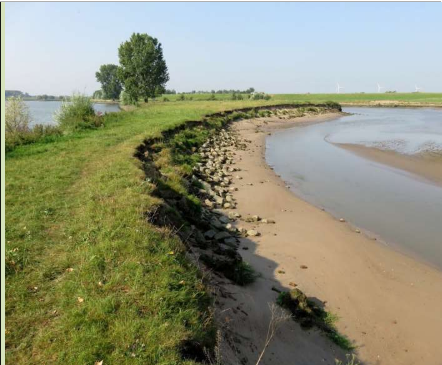
De Horde: afkalving oeverwal
