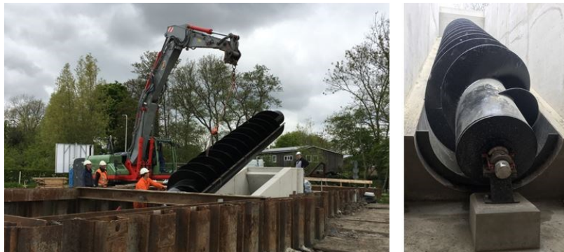
Links: het inhijzen van de vijzel en rechts: de vijzel in het gemaal.
