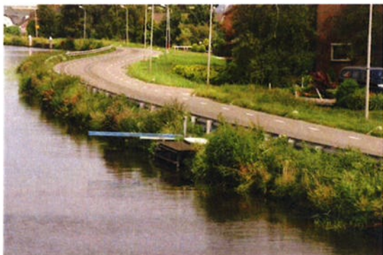
Foto 9: Springplank met steiger langs een openbare oever
