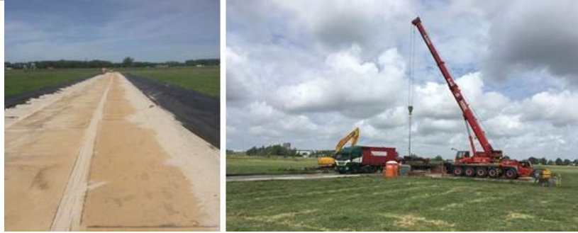
Links: Tijdelijk toegangspad (ruim 1 km) voor het aanvoeren van zwaar materieel en rechts: Materieel om de leiding tijdelijk af te sluiten
