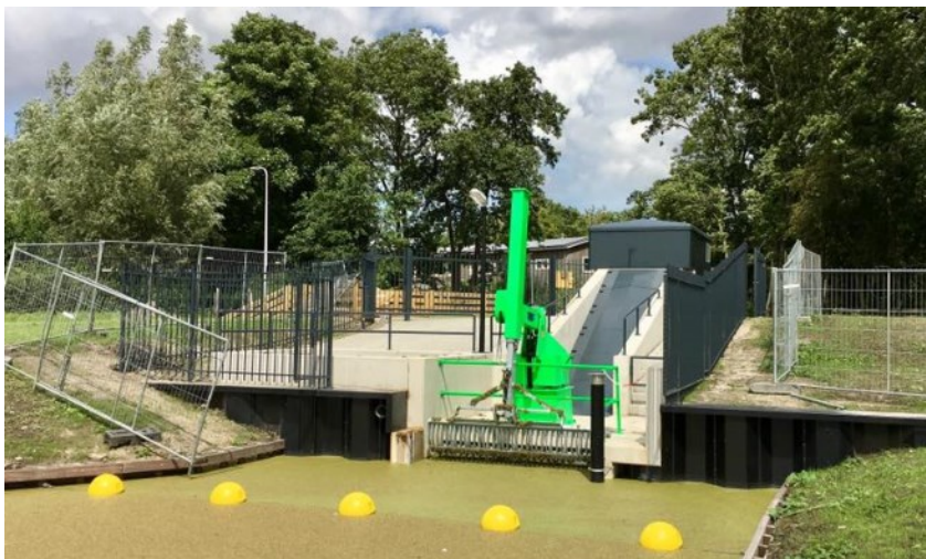
Het nieuwe poldergemaal in de Oostvlietpolder.
