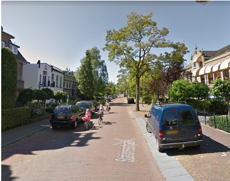
Figuur 18, fietsers en auto's gemengd: Stationsstraat in Alphen aan den Rijn, smal profiel met een intensiteit van ca. 2500 mvt/etmaal, gecombineerd met 4000 fietsers en ingericht met snelheidsremmende maatregelen
