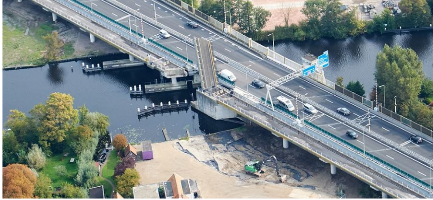
Sloop busbrug over de Oude Rijn/A44
