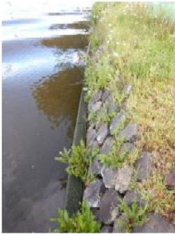
Type 4: schuin talud met basaltsteen
