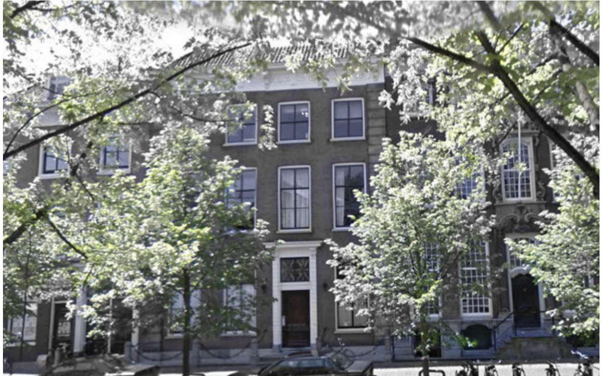
Aanzicht gevels Oude Delft, Delft
