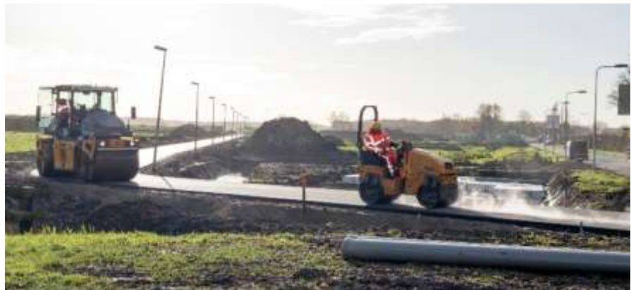
De aanleg van het fietspad bij de Rijksstraatweg (tussen Stevenshof en Wassenaar)
