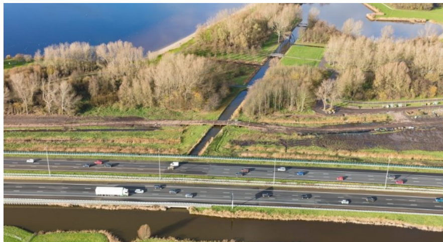
Aanleg hulpbrug bij de Meeslouwerplas
