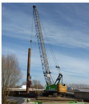
links: aanbrengen funderingspalen viaduct Meerburgerwatering rechts: ingebruikname verlegde Hofvlietweg met ongelijkvloerse kruising voor bouwverkeer
