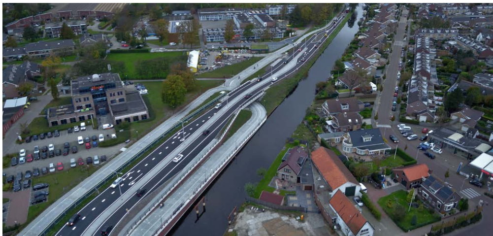
Turborotonde Nagelbrug met fietstunnel in Voorhout. Fotografie: Maurice Hoogeveen
