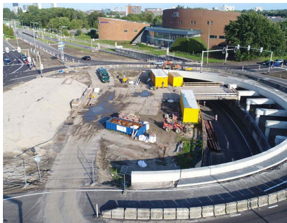
Werkzaamheden aanpassing Baljuwplein
