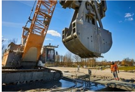
Links: diepwandgraver bij de startschacht boortunnel Rechts: bouw brug over de Oude Rijn A44
