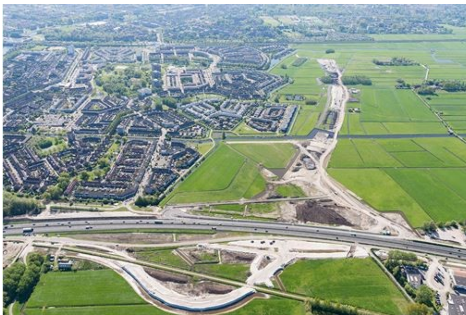
Luchtfoto werkzaamheden toekomstig knooppunt Ommedijk op de A44 en de verdiepte ligging van de N434.
