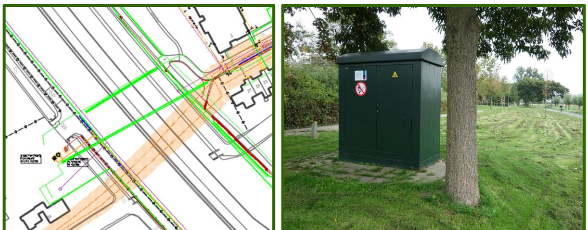
Fig. 8: Kabels en leidingen die dicht langs de bomen lopen vormen een obstakel voor het verplanten. Vooral met de leidingen voor gas en 'gevaarlijke inhoud' en kabels voor middenspanning moet goed rekening worden gehouden.
