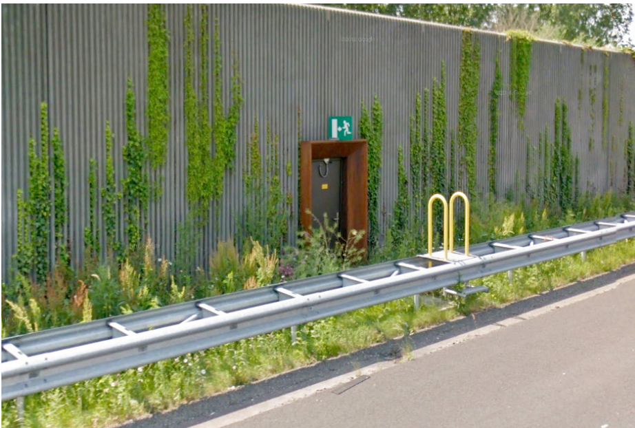
↑ REFERENTIEBEELD VLUCHTDEUR IN GELUIDSSCHERM MET KADER VOLGENS EIS 3.10.3.37 T/M 40
