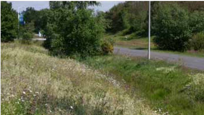
Referentiebeeld beheer voor talud tegen Valkenburg I
