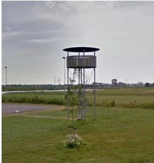
De uitkijktoren bij Eendragtspolder
