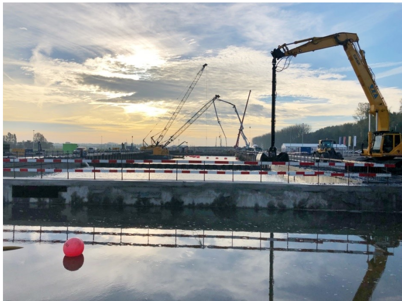
Het bouwterrein aan de de A4 zijde van de tunnel.
