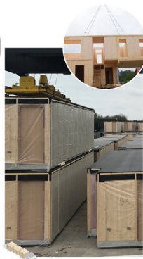
2. efficiënte bouwstroom & logistiek
