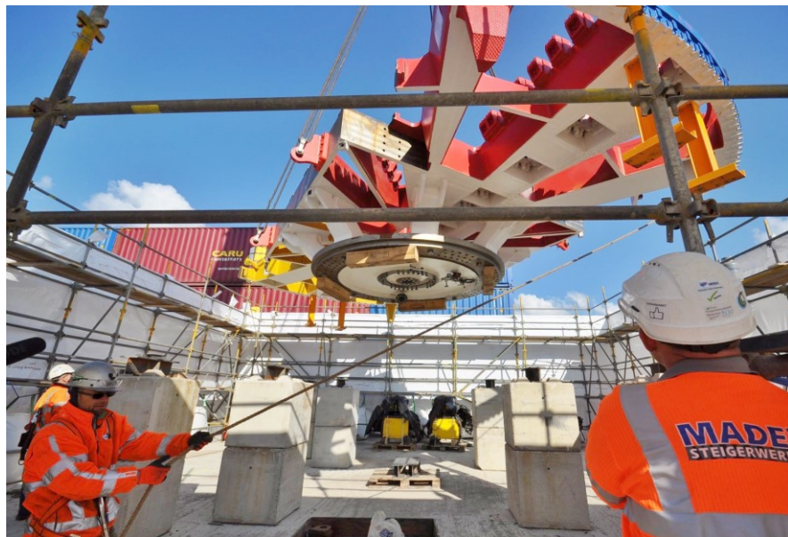
Het lossen van het graafwiel
