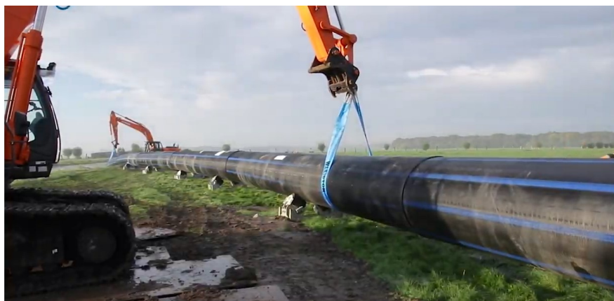
Voorbeeld verlegging drinkwaterleiding.
