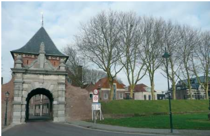
Poortgebouw aan de Lek in Schoonhoven
