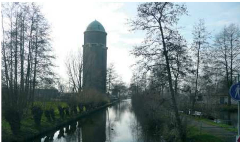
Watertoren ten zuiden van Bergambacht
