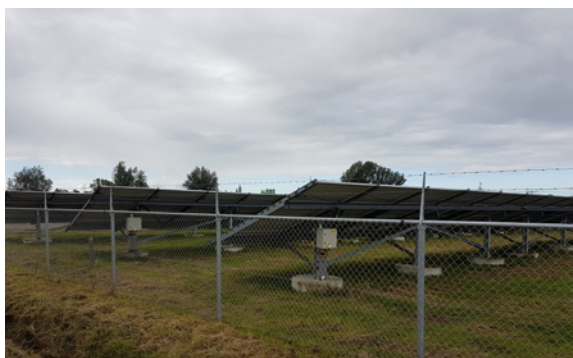
Vermijd zicht op de achterkant van panelen en dominantie Hekwerken.
