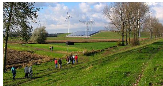
Heldere geometrische vorm zonneveld (vuilstort Waalwijk). (bron: Segaar, P.J. voor Polder PV (2005). Sustainable "fairy tail" in the Netherlands. (bron: www.polderpv.nl/ecopark_Waalwijk )
