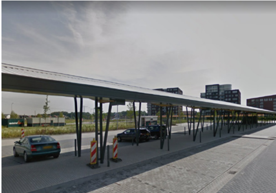
Zonnepanelen als dak boven parkeerplaats.
