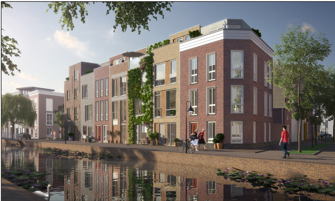
foto: Ballast Nedam Development
