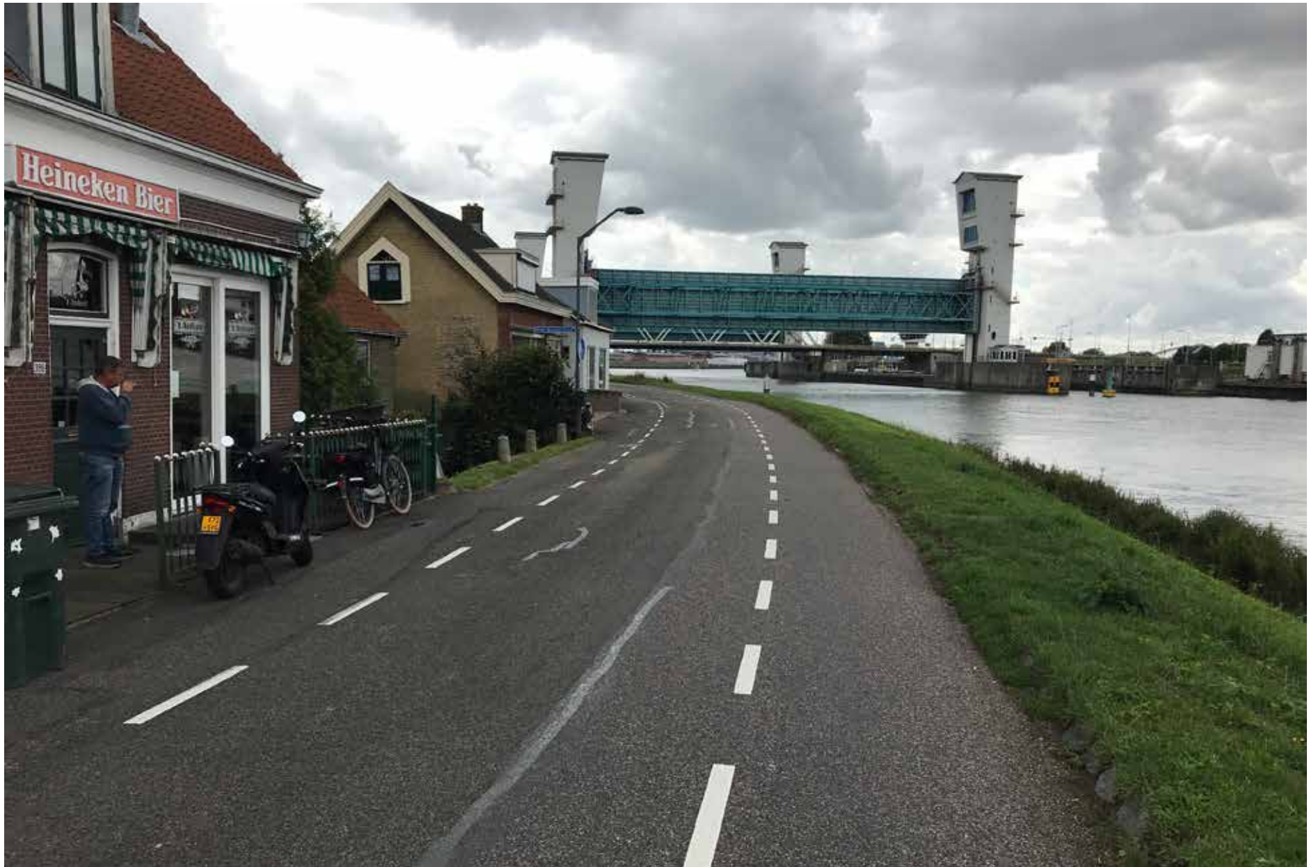
IJsseldijk, Krimpen aan den IJssel, 24 augustus 2020. De Algerbrug is een cruciale verbinding tussen Rotterdam of Capelle aan den IJssel en de Krimpenerwaard. Juist omdat de stedelijke band van Dordrecht-Rotterdam-Den Haag-Leiden nog veel verder zal verdichten zijn deze schakels naar buiten van groot belang. De Algerbrug is dan zowel een vitale verbinding voor de auto, alsook een noodzakelijke schakel voor langzaam verkeer. In feite ben je in ruim een half uur van het Rotterdamse stadhuis in de Krimpenerwaard, met zijn open zichten en de informele dijkclinten die hun eigen charme hebben.
