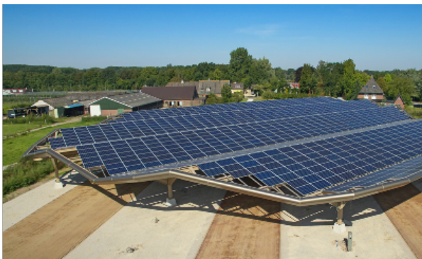
Figuur 11. Parkeervoorziening / laadplein
