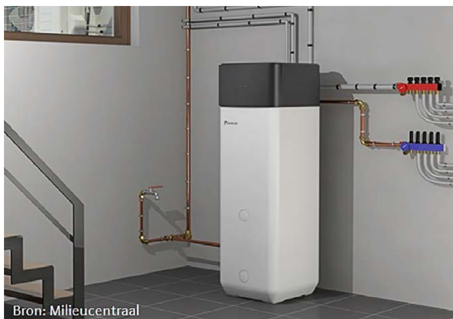
Figuur 15. Voorbeeld van een booster-warmtepomp met voorraadvat
