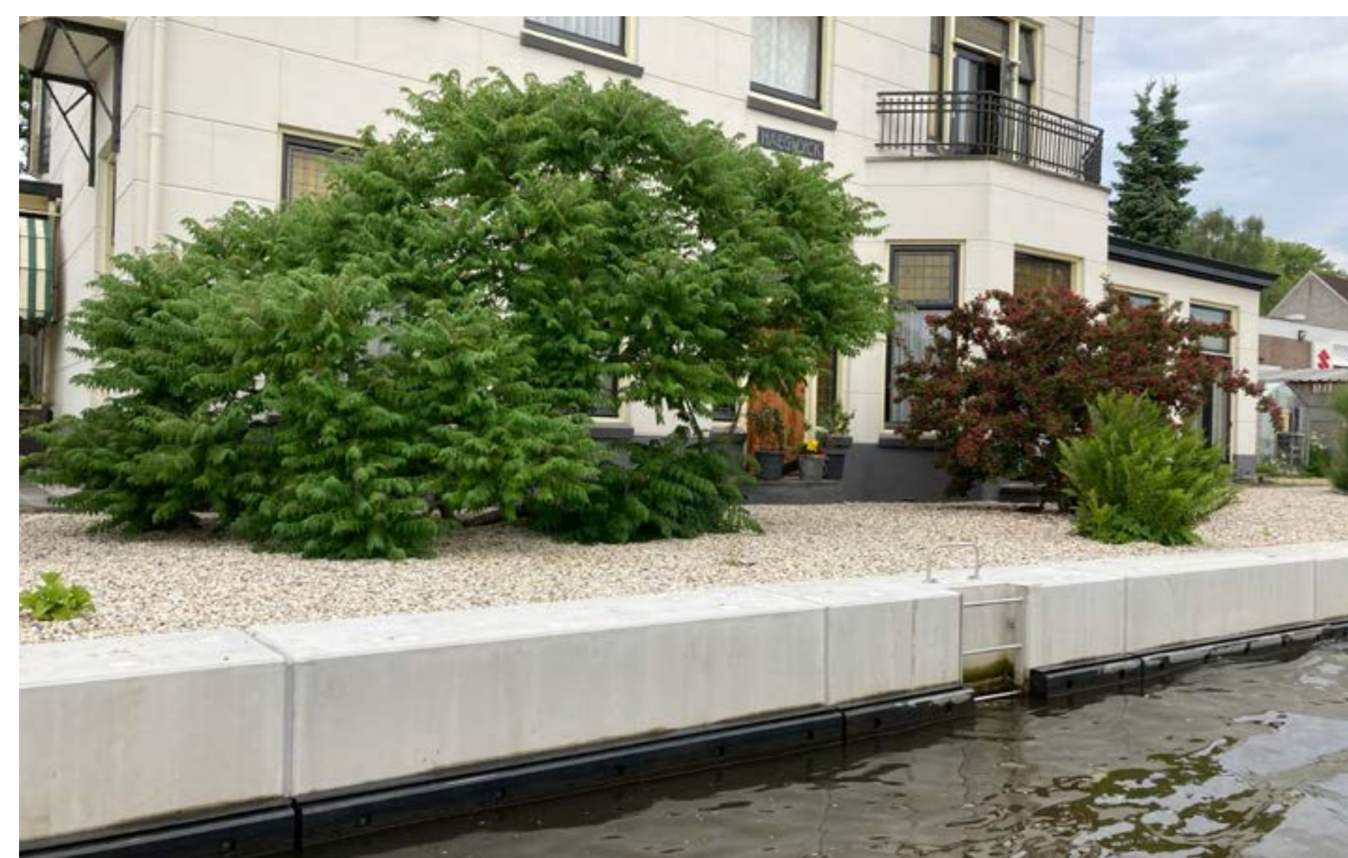
Betonnen deksloof met wrijfgording
