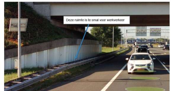
Figuur 8 de ruimte onder het viaduct bij afrit 8
