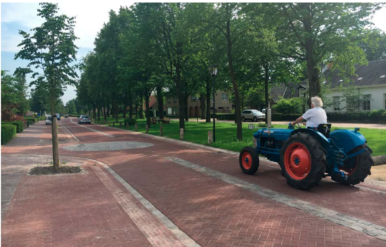
Fietsstraat uitgevoerd in duurzame materialen
