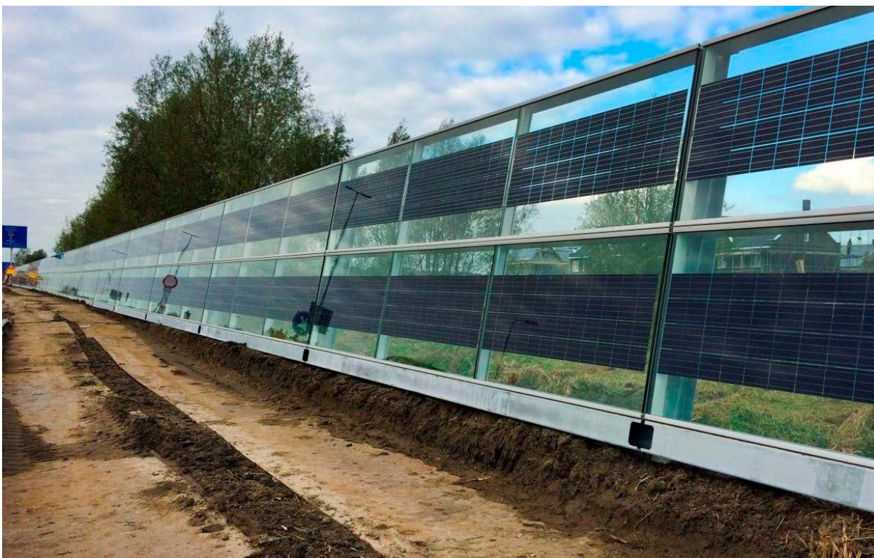
Geluidswerende voorziening met zonnepanelen (Trouw.nl)
