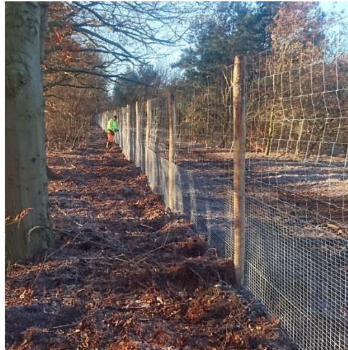
Landelijk hekwerk met faunaraster (bron: Hupkes Hekwerk).
