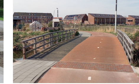
Bestaande houten fietsbrug als voorbeeld voor de nieuwe fietsbrug
