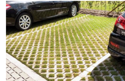
Parkeerplaatsen van grasbetontegels
