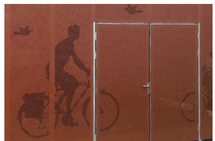
Het zichtbare deel van de fietsstalling krijgt een cortenstalen rooster en is mogelijk afsluitbaar
