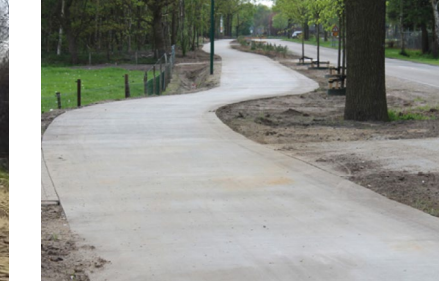
Voetpaden ook uitgevoerd in circulair of duurzaam beton
