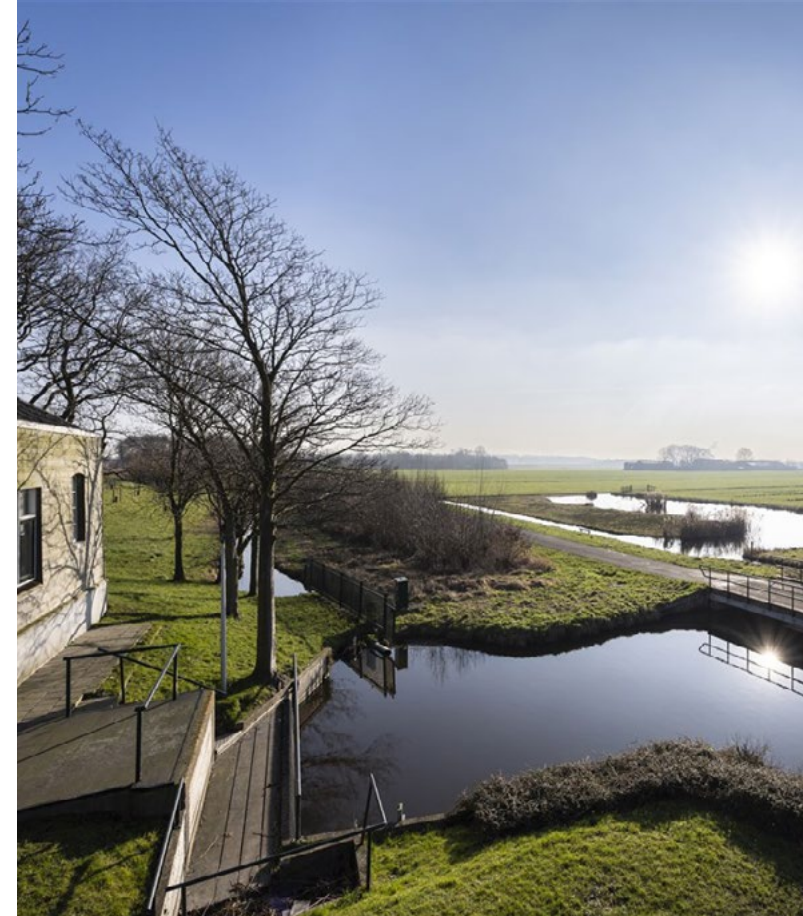
Gemaal van de Duifpolder, Midden Delfland
