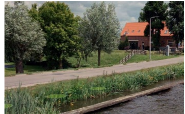
Natuurvriendelijke oever achter damwand Faunapassage langs de N210 in de Krimpenerwaard
