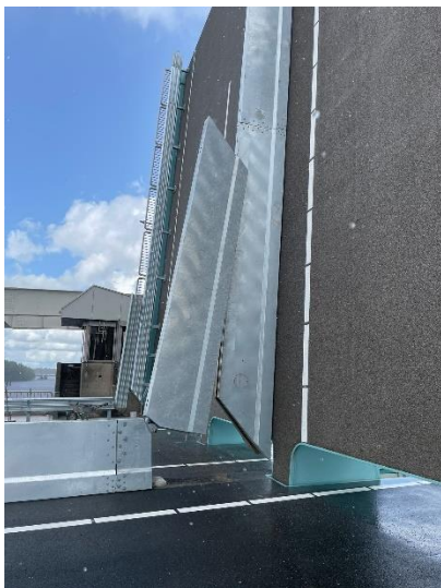
FIGUUR 10 – MOGELIJK PRINCIPE SCHARNIEREND-SCHUIVEND DEEL VAN BARRIER
