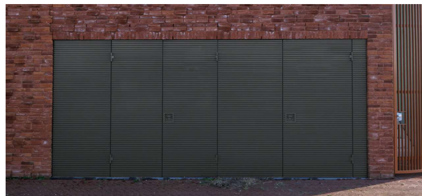
Referentiebeeld trafodeuren met lamellen in gemetselde wand
