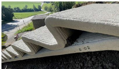
Referentiebeelden 3D geprinte betonnen taludtrappen
