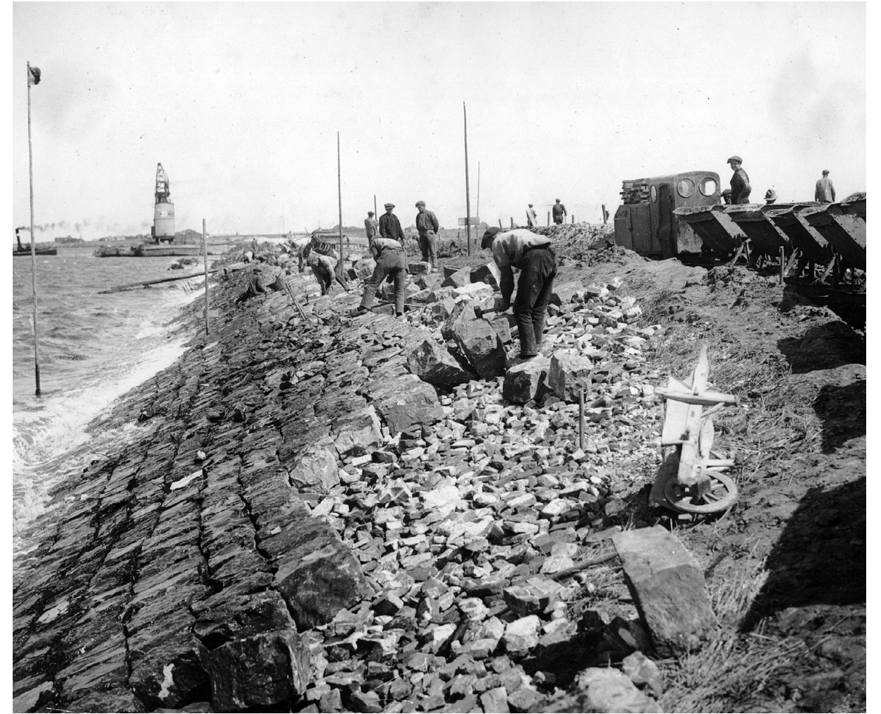
Aanleg van de afsluitdijk, 1932 (Beeldbank Rijkswaterstaat)
