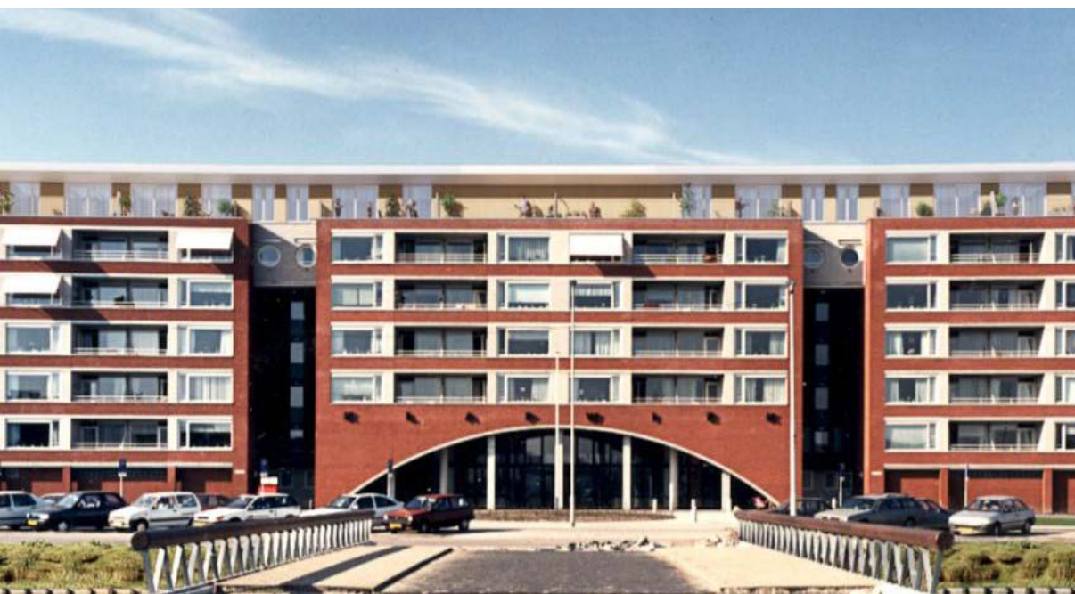
Klapwiek, Rotterdam. 44 extra woningen bovenop bestaand wooncomplex (228 woningen voor ouderen).
