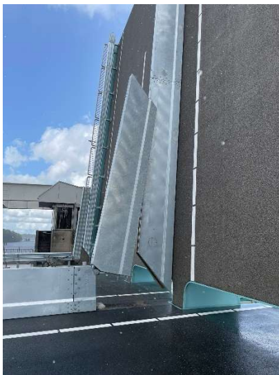
FIGUUR 10 – MOGELIJK PRINCIPE SCHARNIEREND-SCHUIVEND DEEL VAN BARRIER
