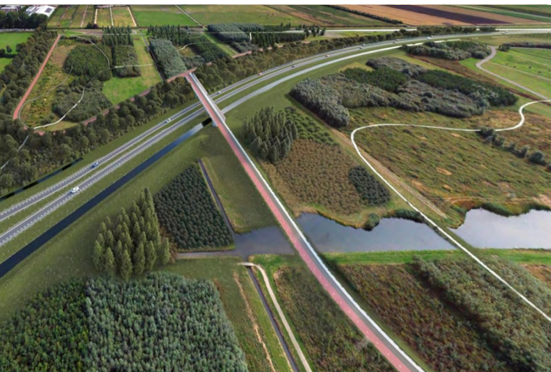
Recreatieve passage over de Verlengde Bentwoudlaan
