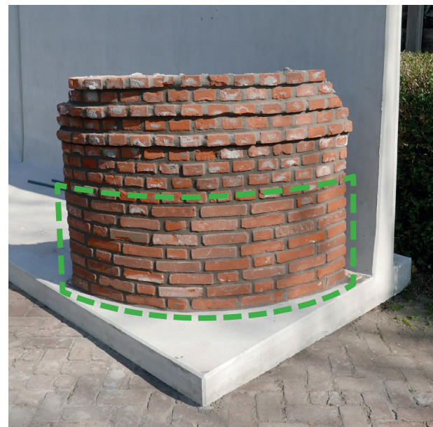
Mock-up afgeronde hoek: onderste deel in wildverband is de gekozen uitvoeringswijze voor de realisatie, maar dan met reliëf
