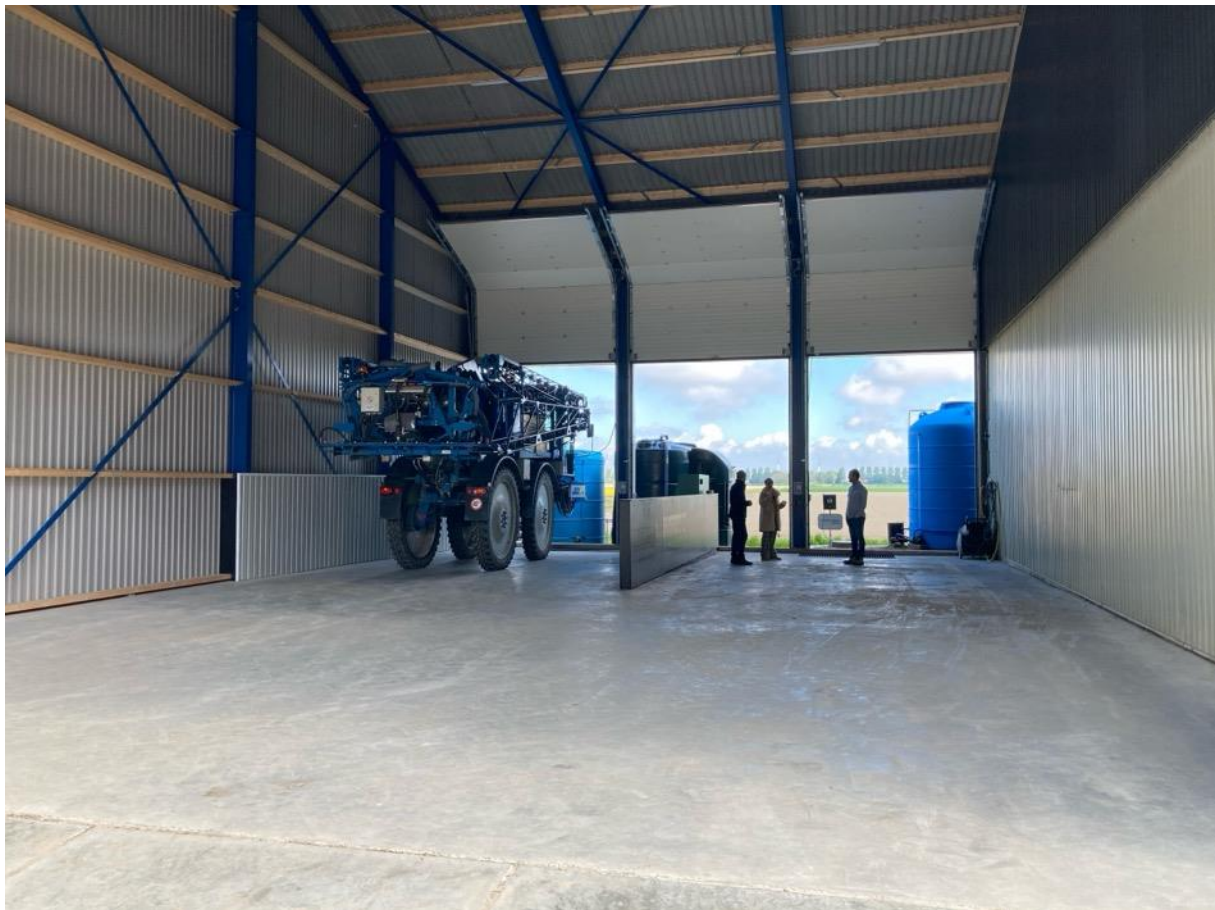
Figuur 6.5 Overdekte gescheiden wasplaatsen, links de vul- en wasplaats voor machines met gbm, rechts de wasplaats voor machines zonder gbm. Dit type wasplaats is in verband met de robuustheid het meest geschikt voor gezamenlijk gebruik.
