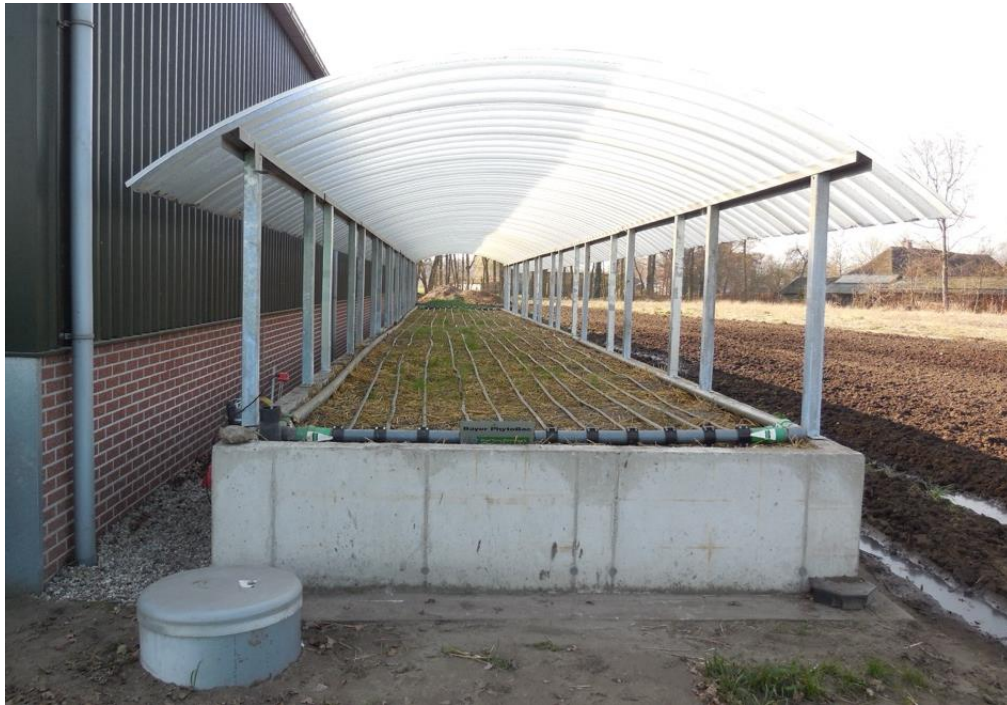
Figuur 4.14 Voorbeeld van een betonnen Phytobac. Deze Phytobac heeft een afmeting van 3 x 25 meter en kan per jaar ongeveer 37m 3 afvalwater zuiveren.
