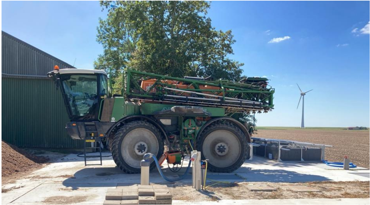
Figuur 4.5 Onoverdekte wasplaats voor machines met gewasbeschermingsmiddelen. Het afvalwater wordt opgevangen en gezuiverd met de RemDry. Na gebruik wordt de wasplaats schoongespoten, waarna regenwater naar een infiltratievoorziening wordt geleid.
