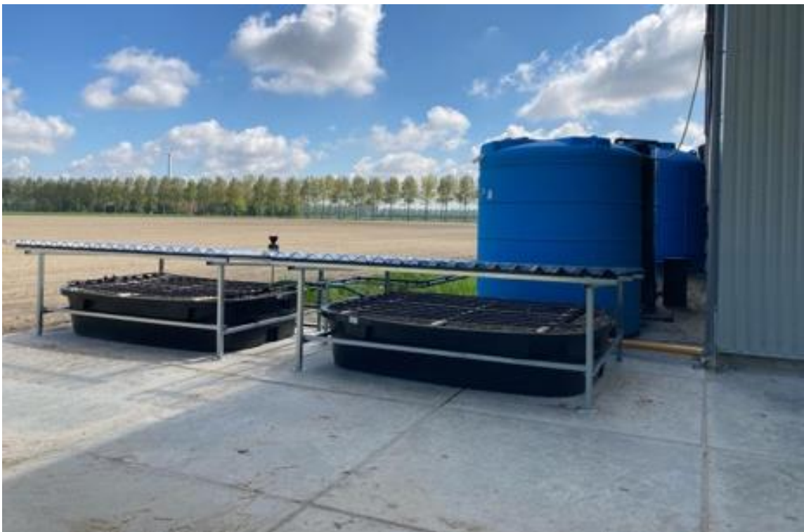
Figuur S2: Voorbeeld van een zuiveringssystem zonder restlozing (op basis van verdamping).
