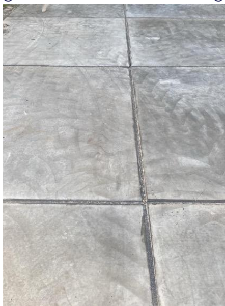
Figuur 6.1 Voorbeeld van aaneengesloten bodemvoorziening: losse betonplaten die gekit zijn.
