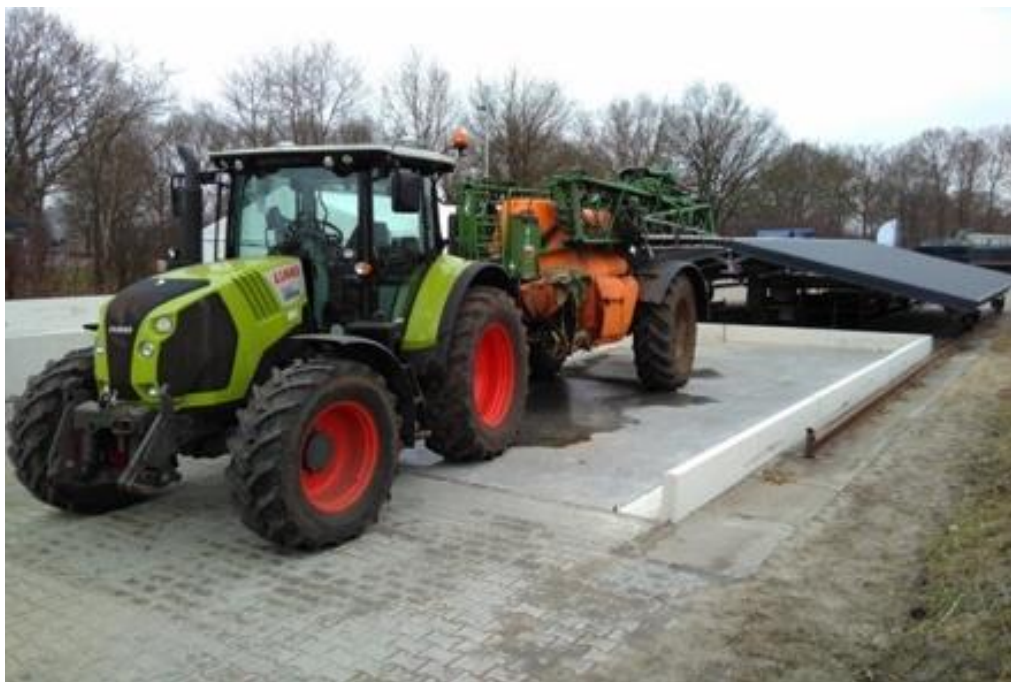
Figuur 4.2 Wasplaats in Wapse met verrijdbare overkapping. Als de wasplaats niet in gebruik is, wordt de zwarte overkapping over de wasplaats getrokken en stroomt het hemelwater naar de bodem.
