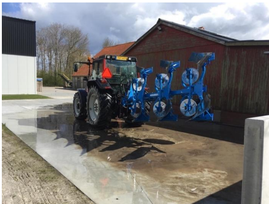
Figuur 4.11 Onoverdekte wasplaats voor machines zonder gbm.
