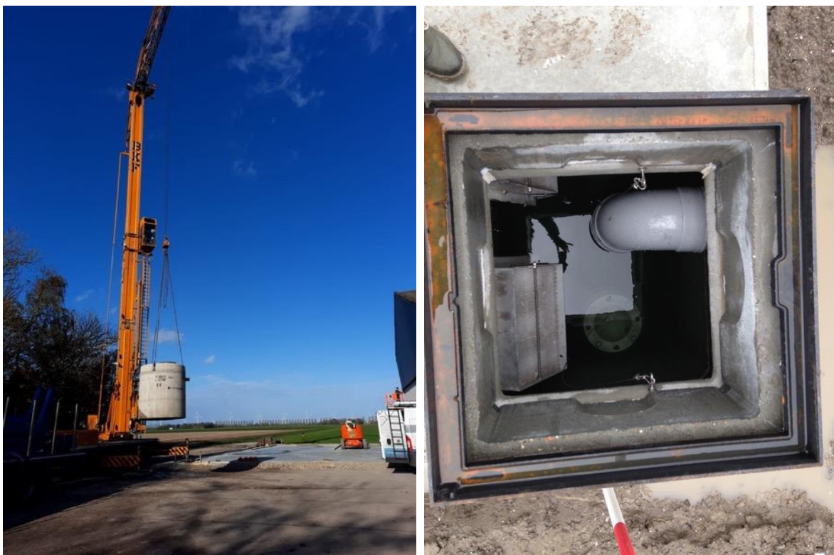
Figuur 6.3 Voorbeeld van het plaatsen van een olieafscheider (OBAS). Een olieafscheider is vaak zo zwaar dat deze met een kraan geplaatst moet worden (links). Rechts: bovenaanzicht van een olieafscheider.
