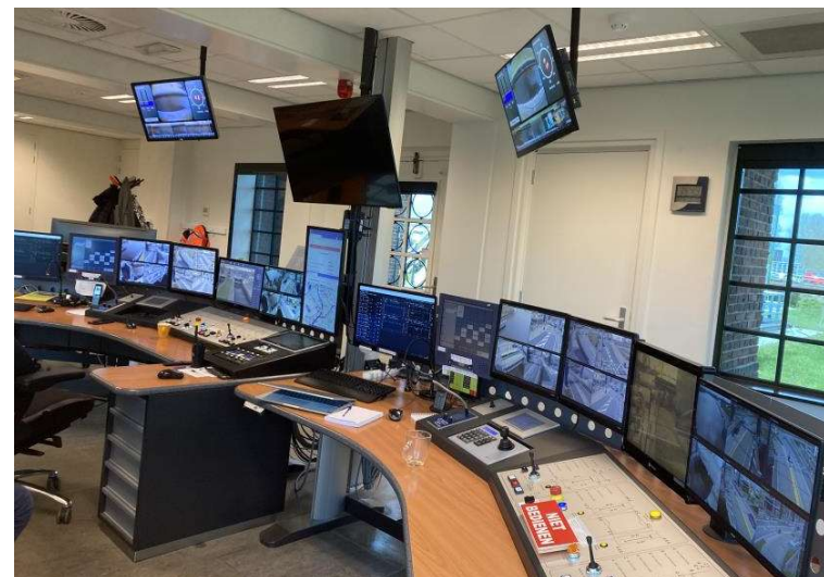
Figuur 9: Twee bediendesks voor de bediening van de Julianasluis.
