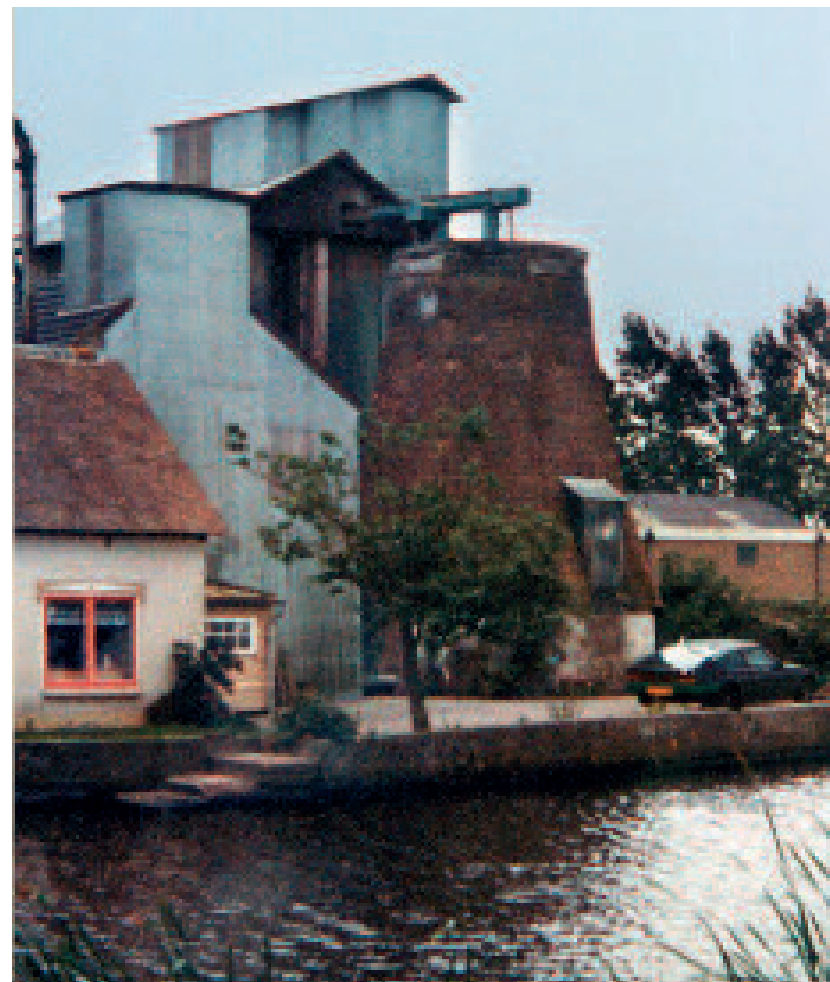
De molenplaats ten tijde van het mengvoederbedrijf in 1970. Van De Jonge Sophia resteert de romp. Via een transportschroef is de graansilo verbonden met de moleanrump. Op de voorgrond de aanlegplaats met stenen stoep voor boten. (Bron: Vereniging De Hollandsche Molen)
